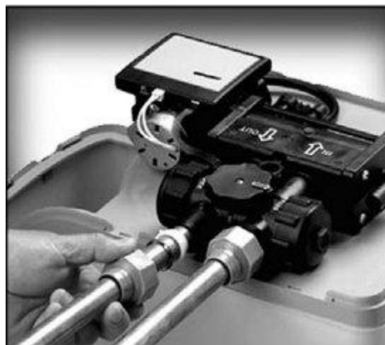
Рис. 5. Подсоединение к водопроводу
